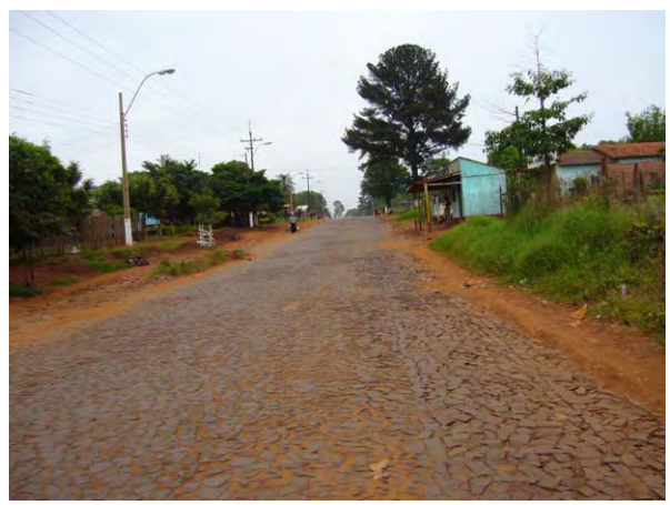
エステ市付近の標準的な石畳舗装区間 (パラナ川沿岸道路)
