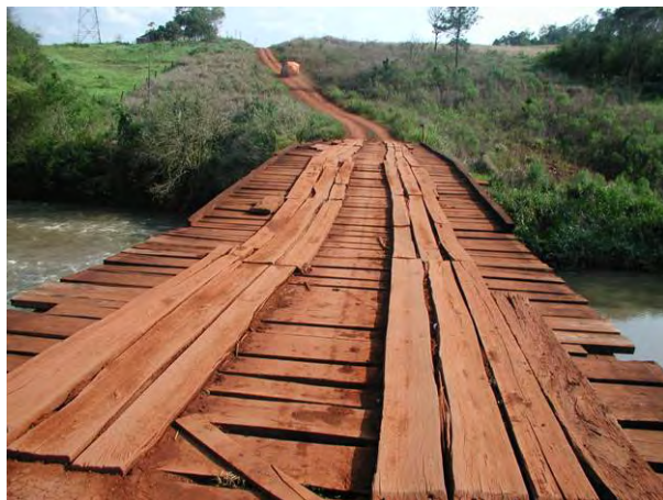
ヤクイグアス川に架かる木橋 (パラナ川沿岸道路)
