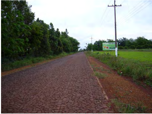
国道 6 号・沿岸道路接続道（石畳舗装区間）
