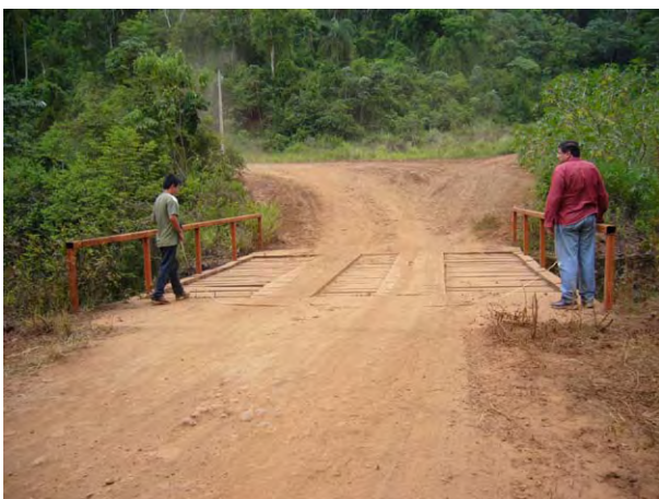
トロクア港へのアクセス道路に架かる橋
