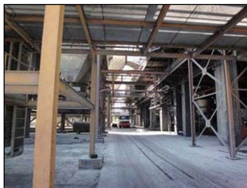
写真 4-1 微粉炭機と電気集塵器間の状態
