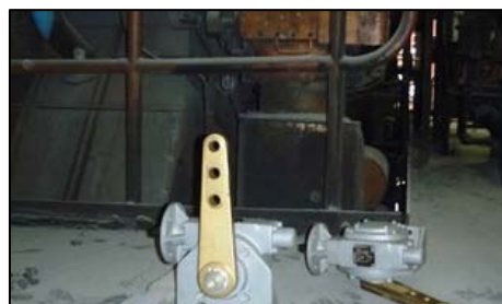
写真4-12 ボイラーの更新後のアクチュエータ
