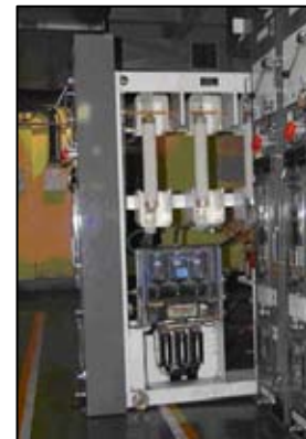
写真 4-25 6.6kV 配電盤
