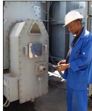
写真 4-23 タップ切換器 のクランクの破損
