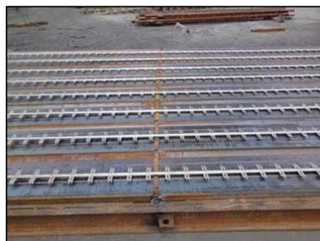
写真 4-14 電気集塵機(リハビリ中の新電極)
