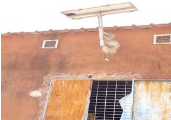
既存 CSPA 簡易型ソーラーパネル
