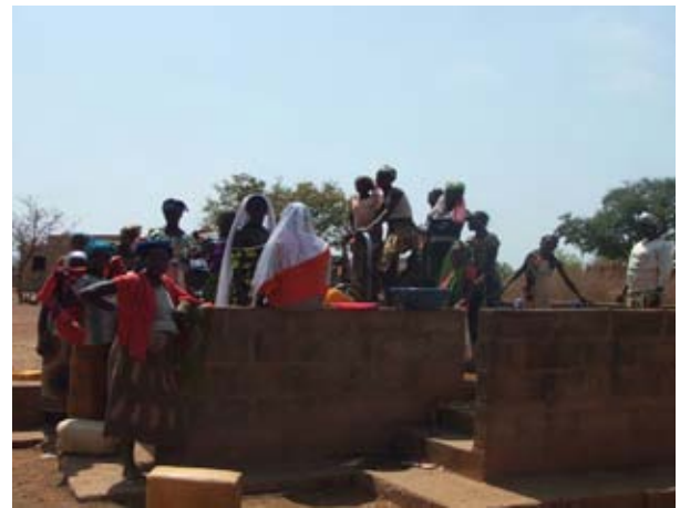
既存 CSPA に隣接する深井戸
