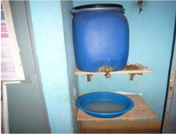
既存 CSPA 室内用水タンク
