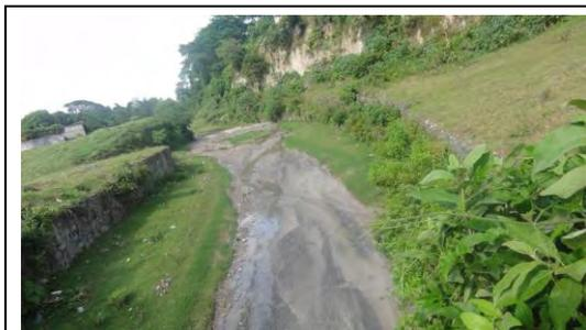
MOP/FOSEP(エルサルバドル投資準備調査基金)により計画された Cuenca Arenal Seco の 3 つの防災調整池の中流サイト。橋梁から上流側を望む。上流側の宅地開発に伴い、右岸(写真右露岩部)の河岸浸食、が進行し最大 15m 後退している。写真右手前のふとん籠護岸は、市が調整シデベロップが設置した。
