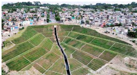
Carcavas (侵食) の対策工事後の状況
