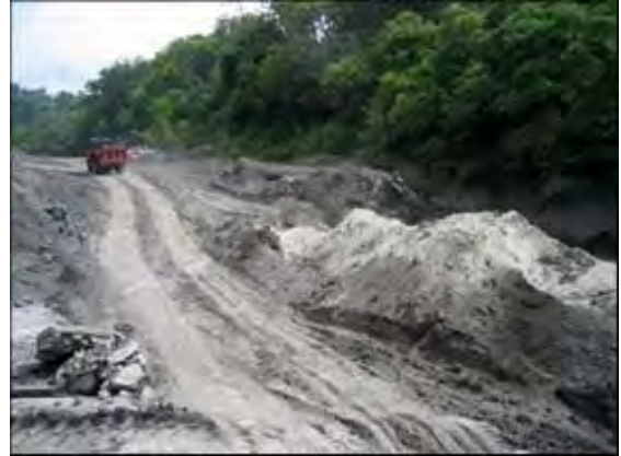
石炭灰捨て場の状況 散水等の飛散防止対策は見られず
