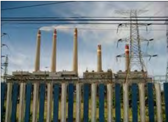
Indonesia Power スララヤ石炭火力発電所 手前が変電施設
