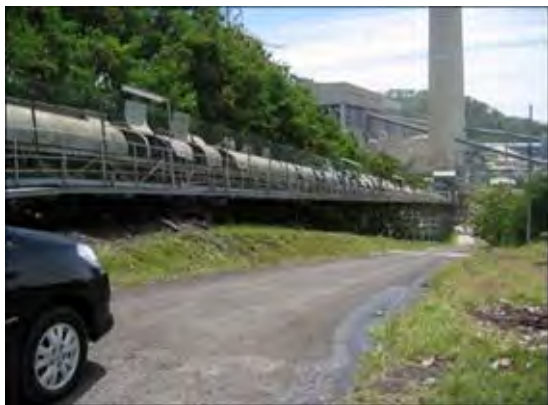
発電所から石炭灰の輸送コンベア 飛散防止用天蓋付き
