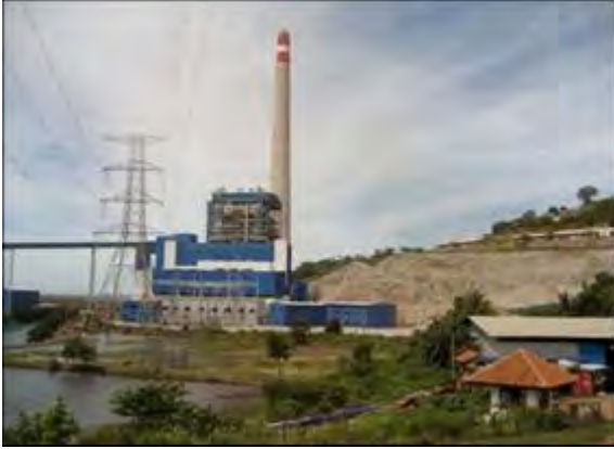
8号機。クラッシュIプログラムで中国が建設 左が温排水の放流施設。手前は沈殿池
