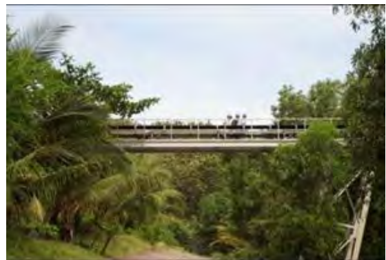
8号機からの中国製石炭灰の輸送コンベア 飛散防止用天蓋なし
