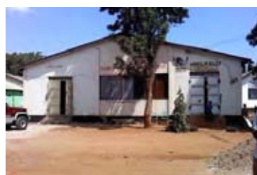
試験場建屋 (TJ Office)
