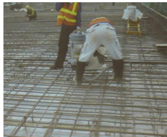
(b) 波形鋼板上での鉄筋配筋
