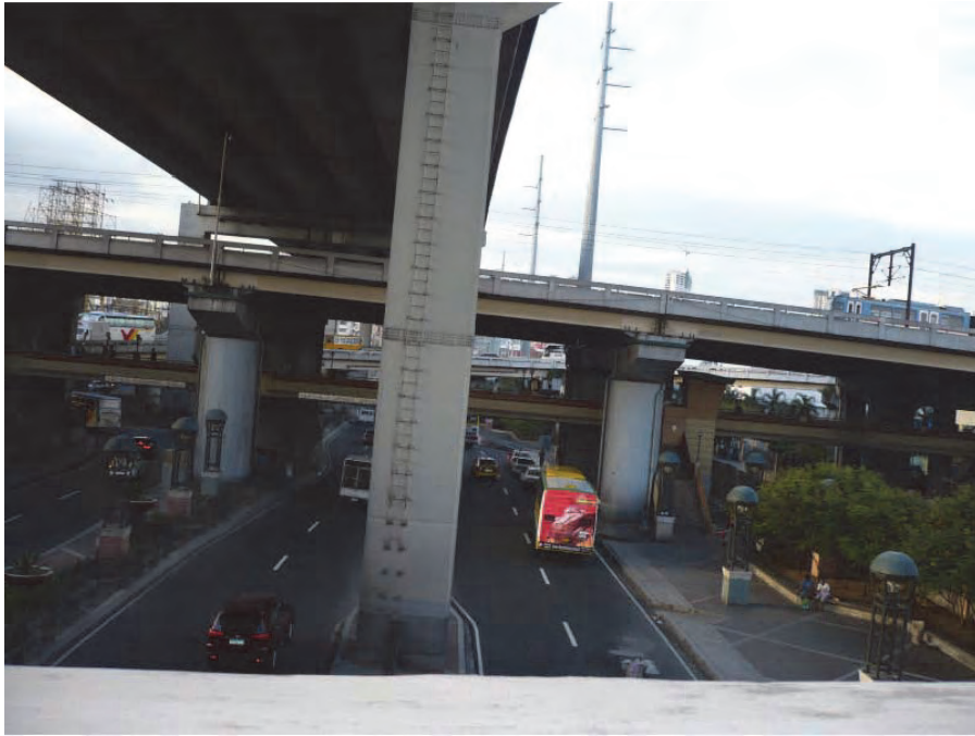
写真 5-4 鋼製橋脚(手前)と鋼板桁橋 (奥)
