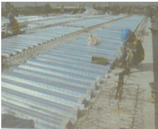
(a) PC橋の床版上面の波形鋼板施工
