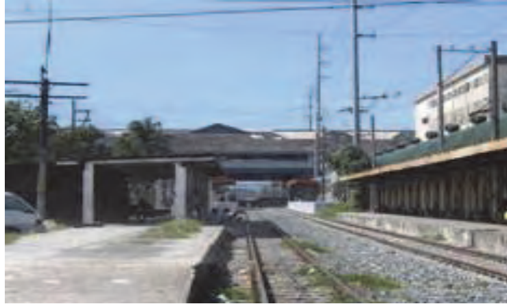
写真 1-3 LRT ブルメンティ駅舎との交差箇所
