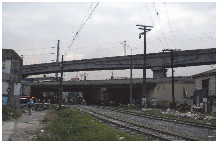
写真 1-2 ラモン・マグサイサイ道路と MRT 高架鉄道をオーバーパスする箇所
