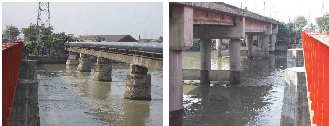
写真 1-4 PNR 鉄橋と水管橋との離隔（左）と道路橋の離隔状況（右）
