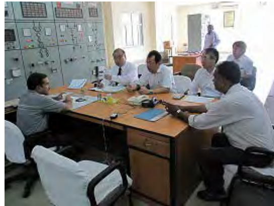
RVPN ニムラナ 220/132kV 変電所
