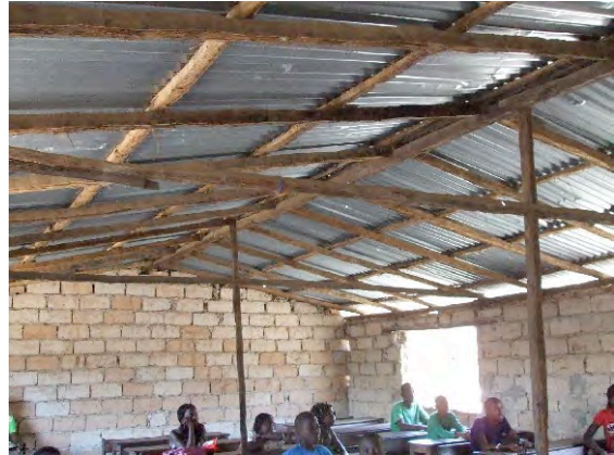
写真 4. No.15 EBU DE CUNTUM II (Anexo Cuntum I) 父母会建設の教室。柱で屋根の自重を支えており、崩壊すると危険な構造。
