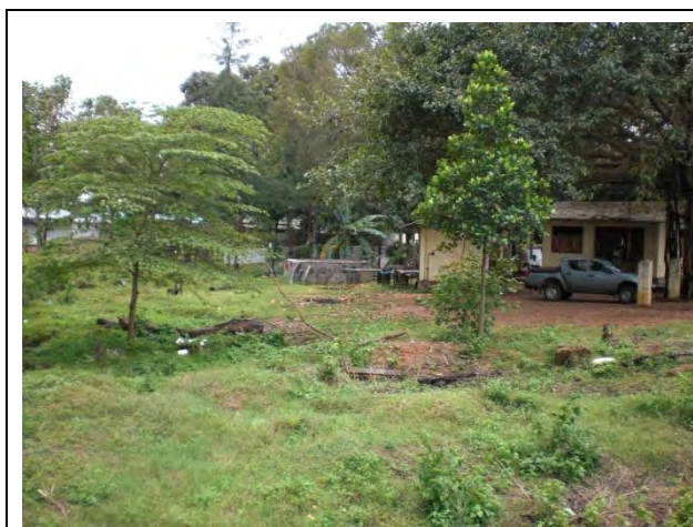
取水施設管理棟全景
