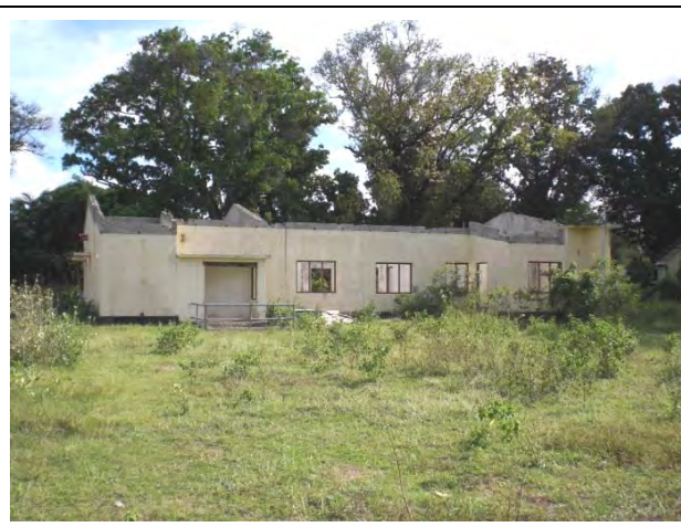
薬品/ポンプ棟・浄水池全景
