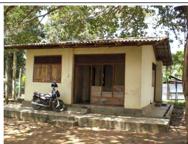
取水施設管理棟建屋
