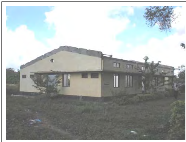
薬品/ポンプ棟・浄水池全景
