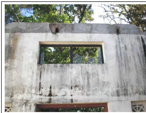
薬品/ポンプ棟・浄水池 屋根取り付け部
