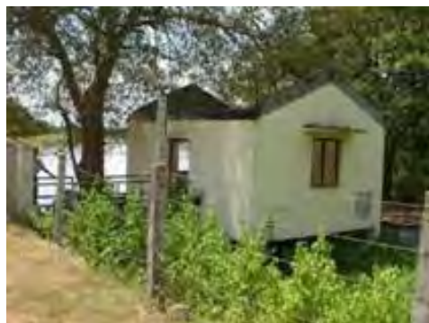
写真-5 : 既存取水ポンプ棟全景
