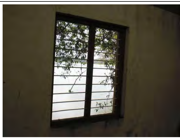
取水ポンプの窓撤去跡
