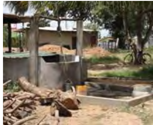
写真-2 : 手彫り浅井戸(A9 国道沿い民家)
