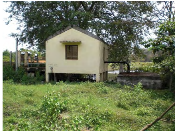
取水タンクと取水ポンプ棟
