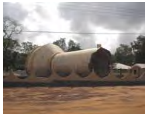
写真-7 : 高架水槽の倒壊状況
