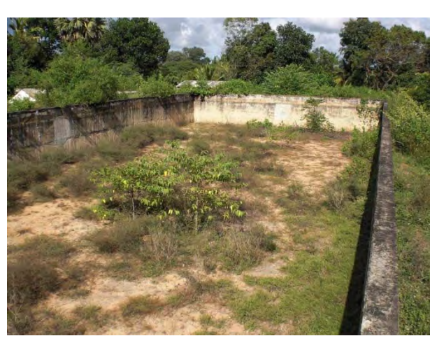
緩速ろ過池全景
