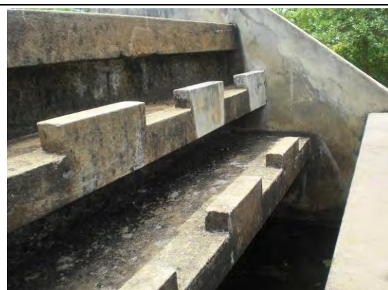
既存エアレータ(段差部)
