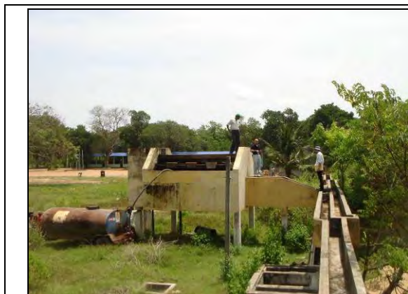
既存エアレータ全景
