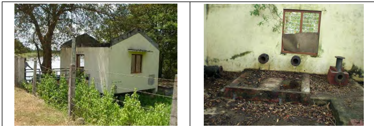
既存取水ポンプ棟全景
