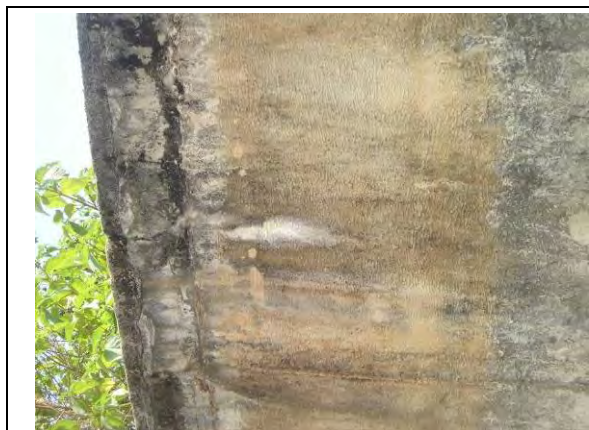
既存緩速ろ過池 内壁
