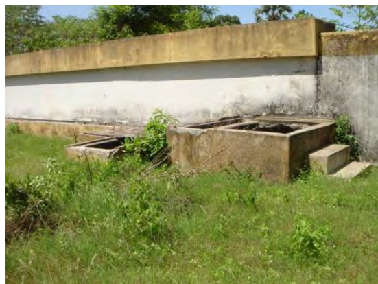
既存緩速ろ過池 外壁
