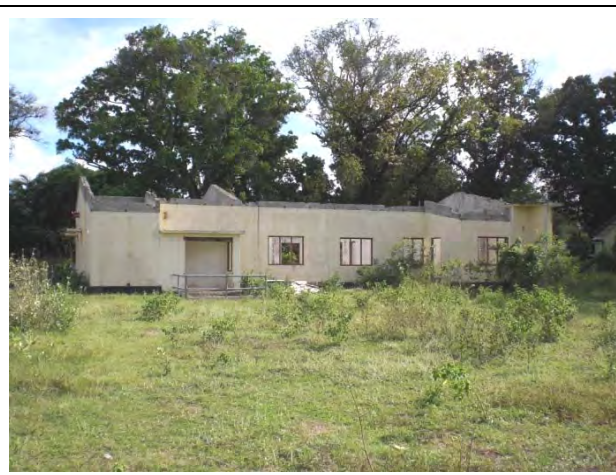
薬品/ポンプ棟・浄水池全景
