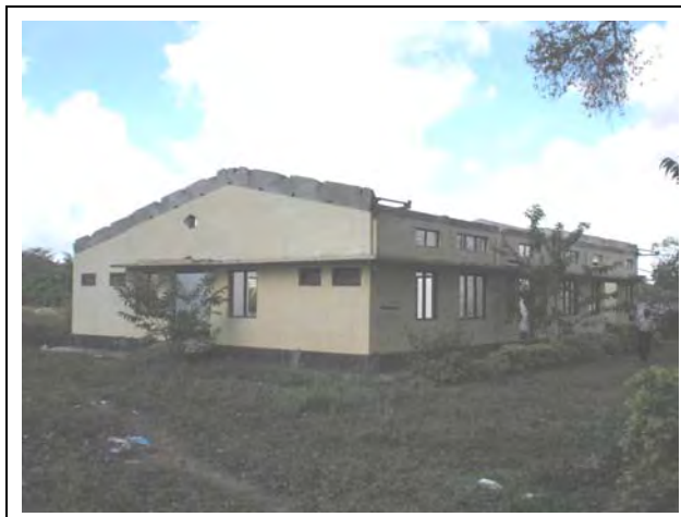
薬品/ポンプ棟・浄水池全景
