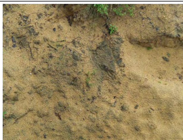
緩速ろ過池ろ過砂
