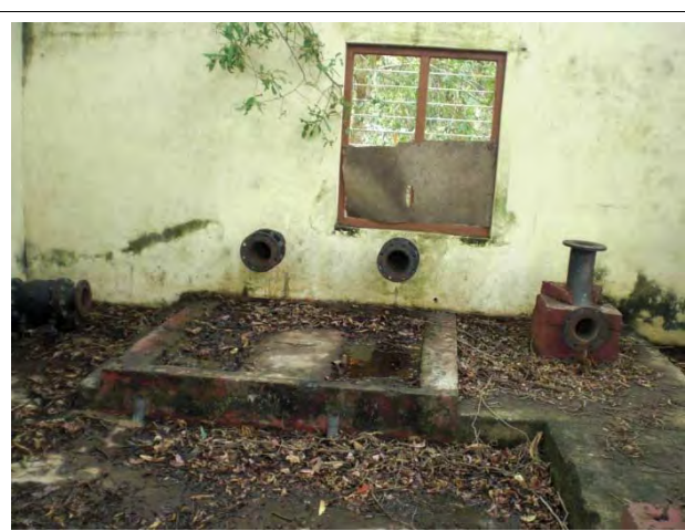
取水ポンプ撤去跡
