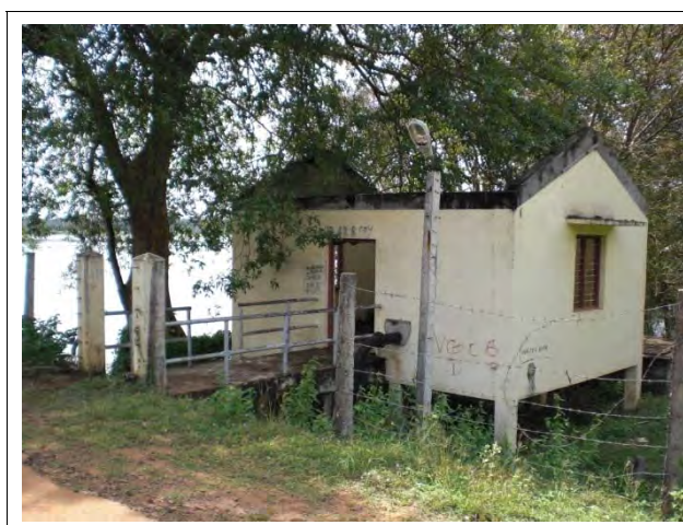
取水ポンプ場全景
