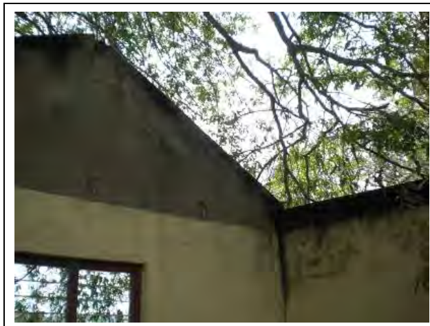
取水ポンプ場の屋根撤去跡
