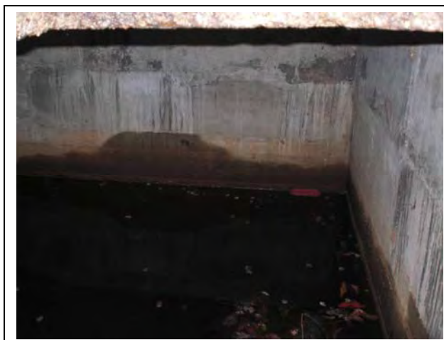
取水タンク内面
