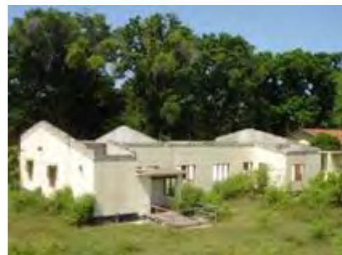
写真-6 : 既存管理棟全景
