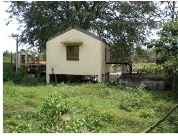
取水タンクと取水ポンプ棟
