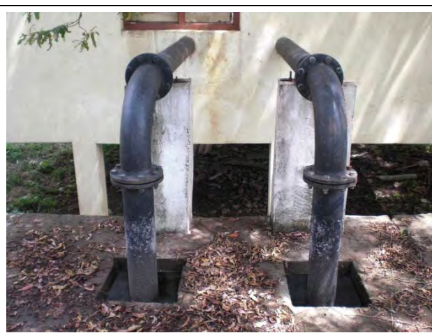
Sump～取水ポンプ棟への流入管
