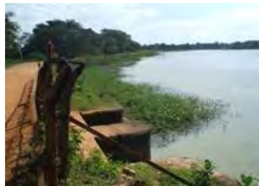
写真-4 : Dry Aru (2) -取水地点-
