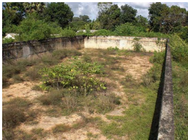
緩速ろ過池全景
