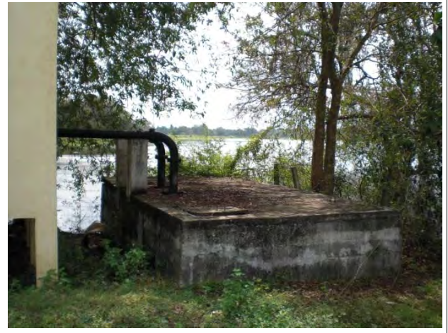
取水タンク全景
