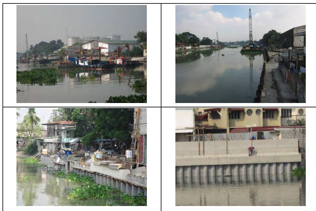
図 3.5.3 パッシング川における類似工事の状況（2011 年 2 月）
