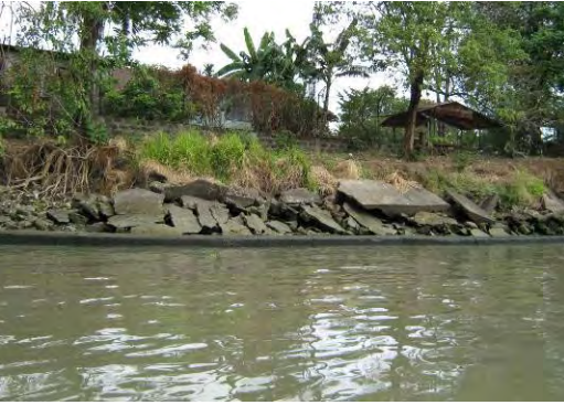
詳細設計後に損傷した護岸工 (フェーズII 区間)
