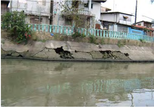
詳細設計後に損傷した護岸工 (フェーズII 区間)
