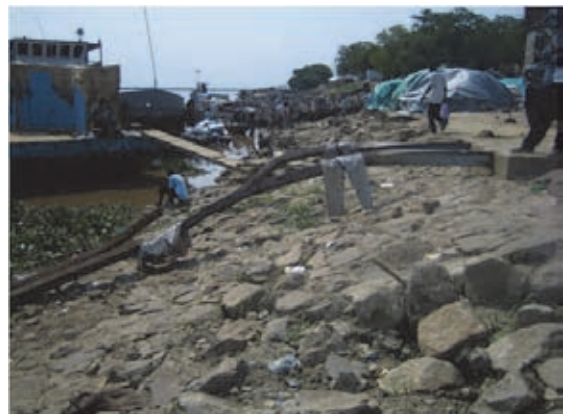
写真5-38 階段護岸のさらに北側の護岸
