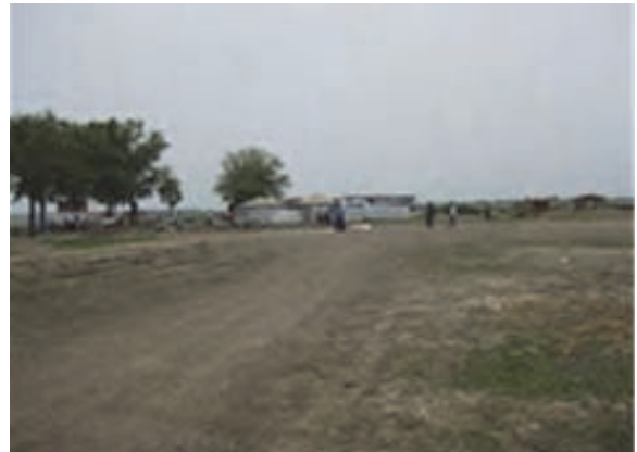
写真 5-13 SI によるパッケージ型浄水施設外観②
