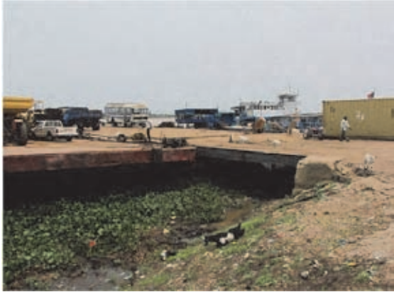
写真5-33 係留棧橋（バース延長は10m程度しかない）
