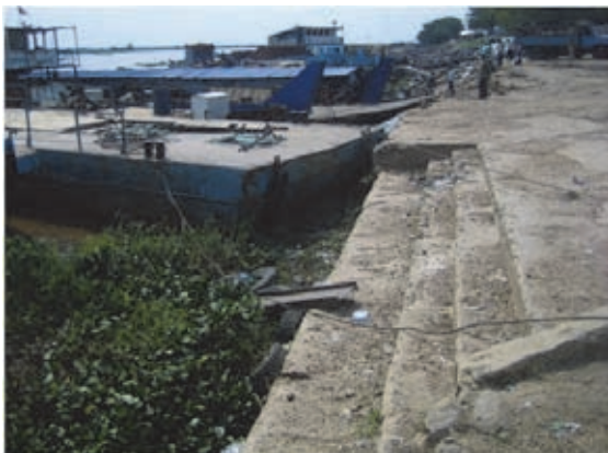
写真5-37 係留棧橋北側（上流側）の階段護岸
