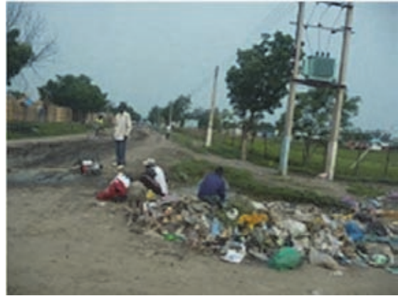
写真 5 - 2 排水路はごみと水で埋まっている。
