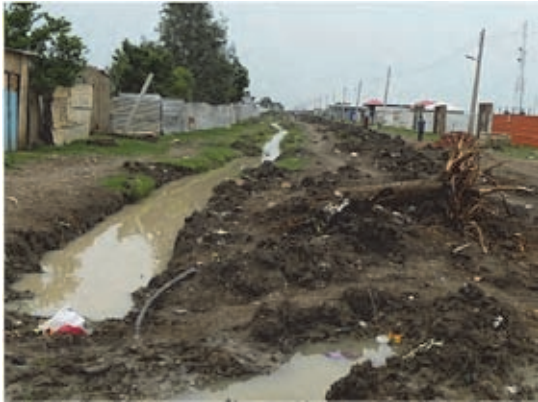
写真 5 - 1 市内道路の様子
