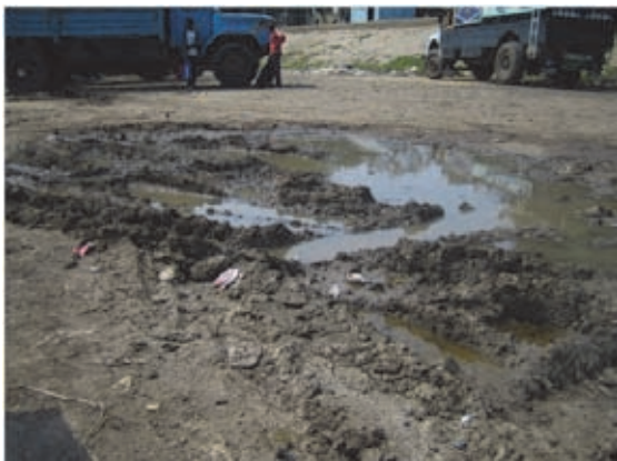
写真 5-47 ヤードの状況
