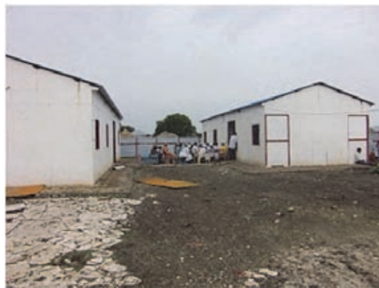
写真 5 - 23 Assosa ヘルスセンター外観②
