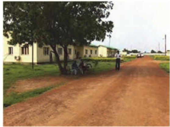
写真 3-17 ADRA コンパウンド敷地内部
