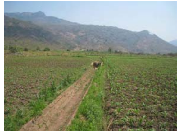
不適切な水準設計で取水できない水路 (マチンガ県Chanyungu地区)
