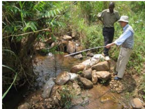
石と土のうを使った取水堰 (ムランジェ県Nijilimbi村)
