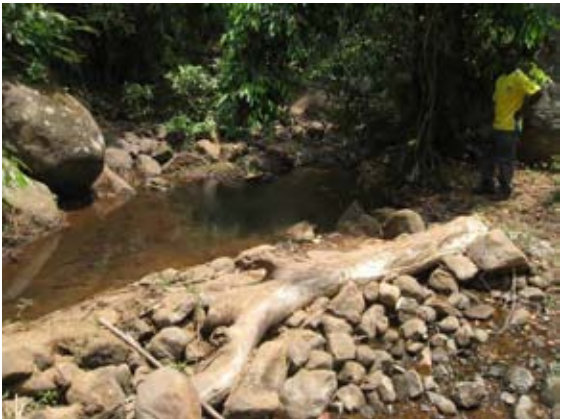
倒木と石を使った取水堰 (ゾンバ県Likwenu地区)
