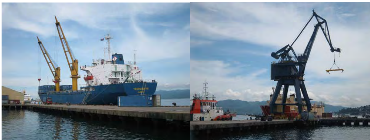
アンボン港埠頭 — 停泊船、クレーン
