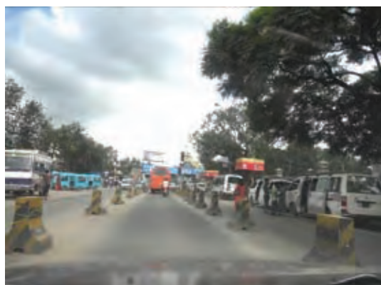
ラムシャハパス (ロープ付き簡易 ブロックで車線を分離)
