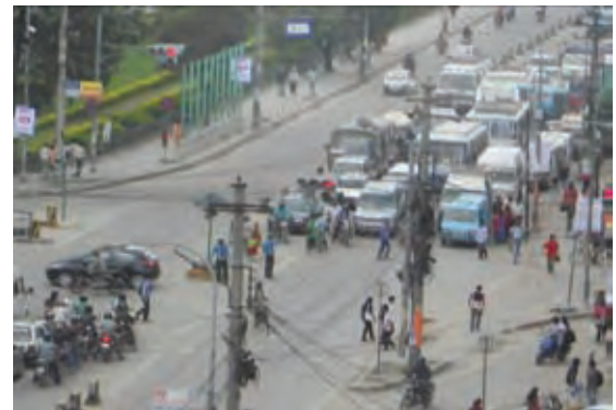
ナヤバネシュウォール交差点 (日本の ODA で整備)
