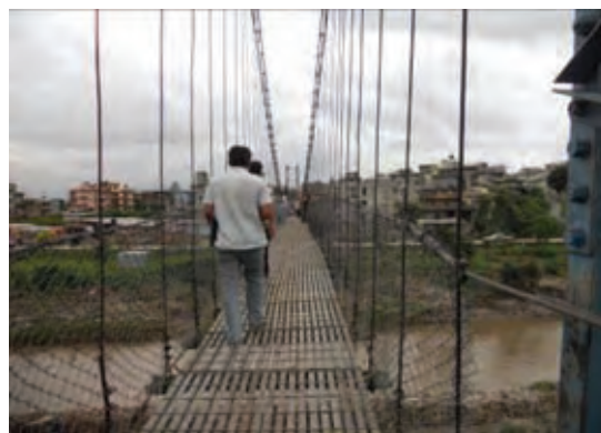
マノハラ橋に架かる吊橋カモル橋
