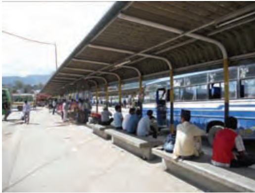
ゴンガブのバスターミナル (日本の ODA で整備)
