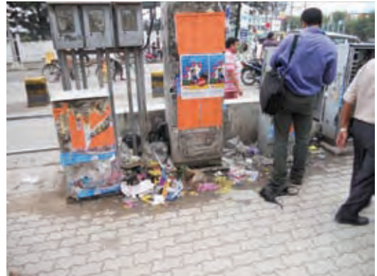
配電盤と分電盤の間のスペース
