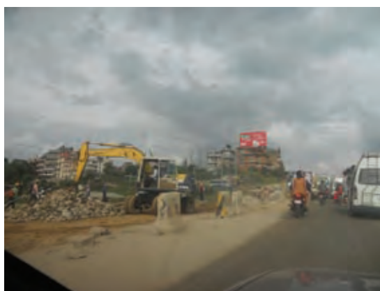
整備中の道路インフラ：日本のODAにより4車線化工事の進むアルニコ・ハイウェイ。都市部の4車線拡幅は困難の連続
