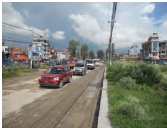
未整備な中央分離帯：既存のリング道路は損傷が激しく、交通量も多いことから中国政府による4車線化改修をネパール政府は期待している。
