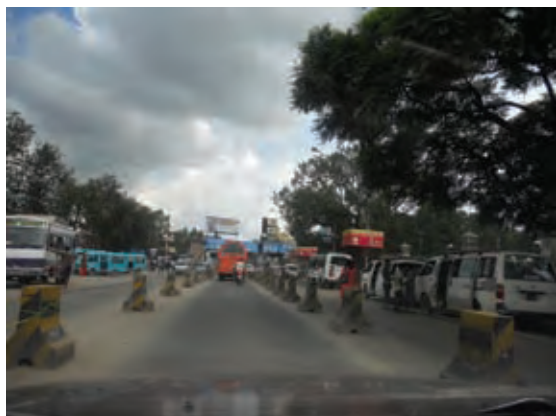
未整備な中央分離帯：カトマンズ市の中心部のラトナパーク付近。コンクリートブロックで交通流を制御している。
