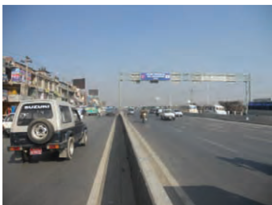
整備された中央分離帯：日本のODAにより4車線化が完了したアルニコ・ハイウェイのコテスウォール地区。中央分離帯の設置により交通流が大幅に改善している。
