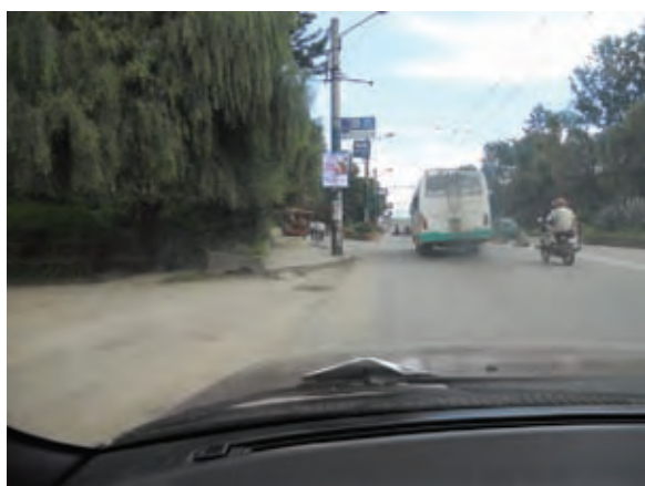
未整備な中央分離帯：ババルマハール付近の主要国道アルニコ・ハイウェイ。片側2車線で整備されているが中央分離帯がない。
