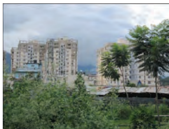
リングロード沿い近くに建設されたアパート
