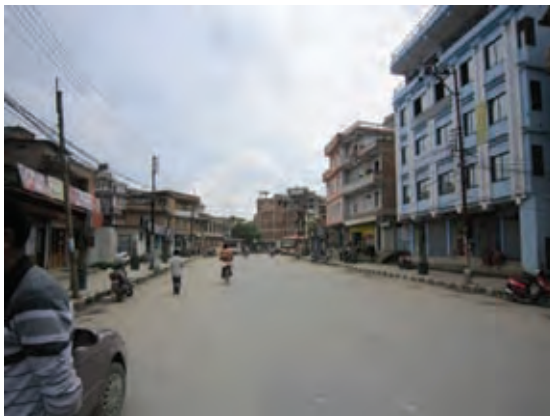
区画整理で整備された Kushibun～Nayabazar間の広幅員道路
