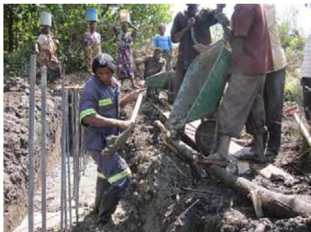
鉄筋コンクリート堰基礎底版のコンクリート打設の状況。堰の高さは 1.8m、堰幅は 12.5m (Nseluka 地区、Mungwi 郡)。
