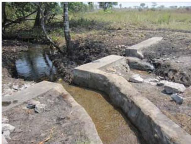
堰は練り石積みタイプで表面はモルタルで仕上げている。堰の高さは 2.0m、堰長は 12.0m である。手前が灌漑水路の始点部、奥に見えるのは土砂吐きである（2010 年 9 月末日）。
