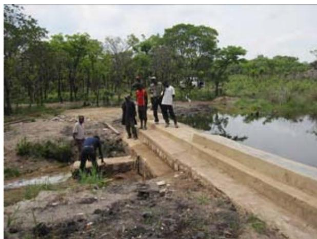
完成になった練り石積みタイプ恒久堰。堰の高さは 1.8m、堰幅は 24.0m である。写真は工事関係者により細部の最終確認が行われている様子 (2010 年 11 月初旬)。
