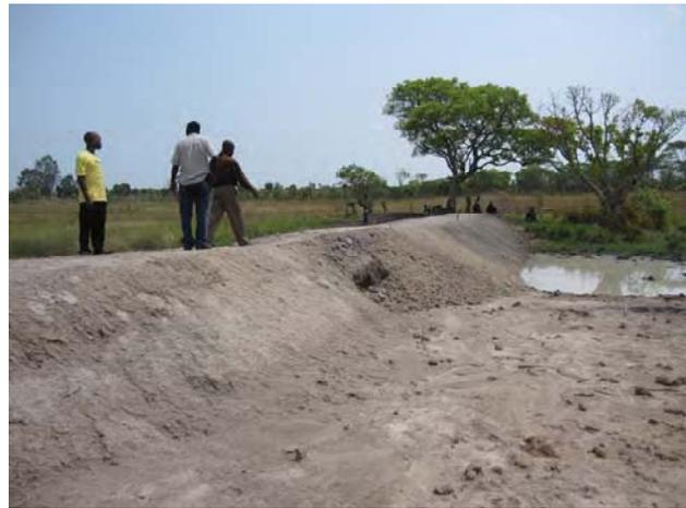
計画高さまで盛り土施工が完了した小規模フィルダム（2010 年 11 月初旬）。
