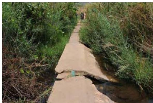
ダンボ内に建設された恒久堰の一例であるが、20cm を越える不等沈下が発生している。
