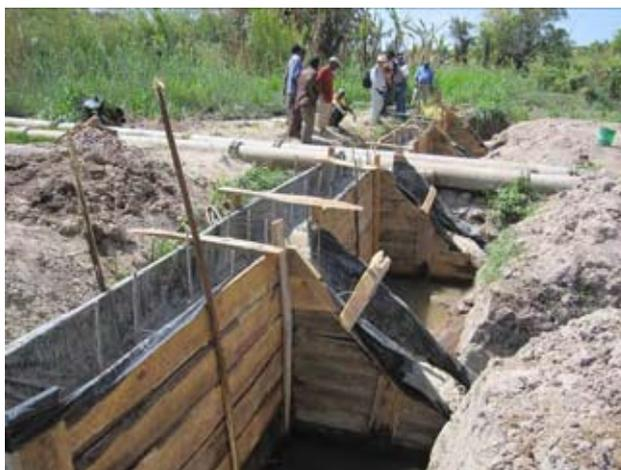
堰は鉄筋コンクリートタイプである。堰の高さは 2.3m、堰長は 15.0m である。写真は最終層のコンクリート打設前の状況。このあと堰工事は完了し灌漑農地への送水を開始した（2010 年 9 月中旬）。
