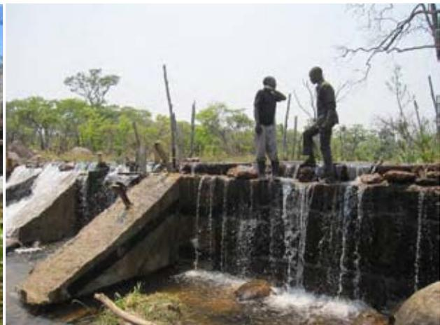
グレードアップ工事により堰の全てがコンクリート造に置き換えられた。堰の高さは 1.3m~1.9m 程度、堰長は 41m であり、今回建設された 8 恒久堰のなかでも大型のものとなった（2010 年 9 月下旬）。
