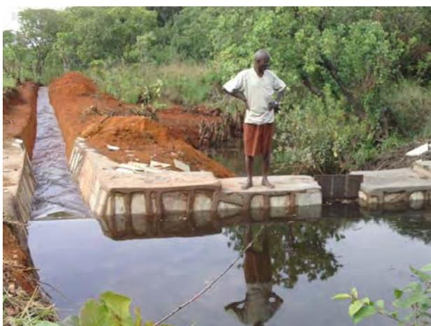
堰の高さは 1.6m、堰長は 13.0m である。恒久堰による安定取水により、今後灌漑面積の拡大につなげる計画である（2010 年 11 月中旬）。
