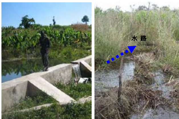
左写真はコンクリートで建設された典型的な恒久堰、また、右側は農民レベルで建設された簡易の灌漑施設（多くは河川から水路に水を直接引き入れているだけのものが多く、写真のような簡易堰を持つものは少ない）。
