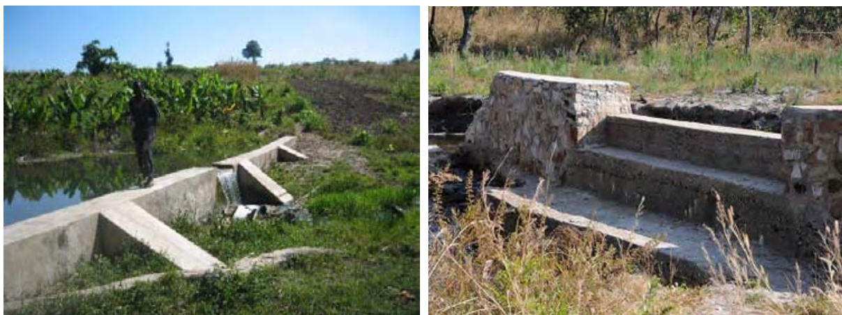
調査対象地域における恒久堰の代表 2 例：コンクリート堰（写真左）、粗石モルタル堰（写真右）。2000 年前後よりドナー資金あるいは政府予算によりこうした恒久堰が建造されてきた。それらの多くはコンクリート堰であるが、写真右に示す礎石モルタル堰のものもある。
