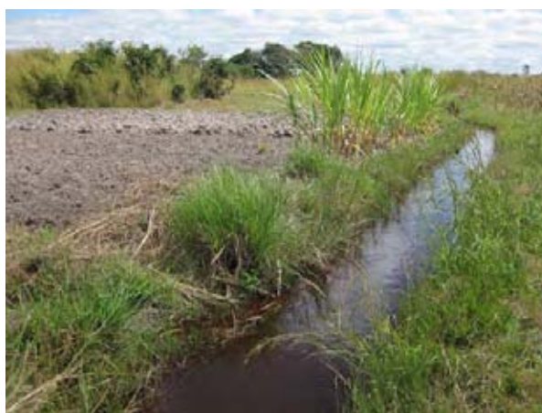
Kalupa 村（北部州 Mungwi 郡）における水路：河川水位と受益地標高差を利用し、堰を有さず用水路のみで灌漑用水を導水している。
