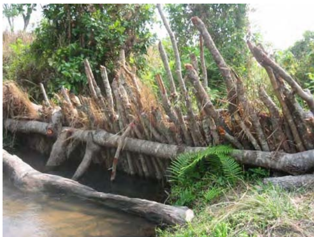
インクラインド簡易堰の一例である。大型の横木を河川を横断して渡し、その前面に枝、草、そして粘土を置いて水位を上げている。また、横木を背面より支える支柱を2本ほど設置している。
