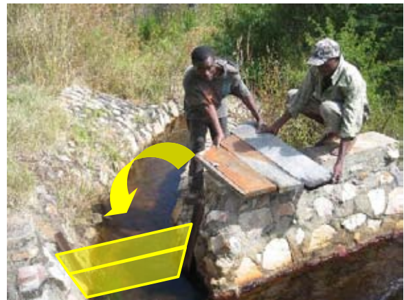
一方、木板の角落としにより水管理を行う施設もあるが、こうした設備を具備する灌漑スキームの数は少ない。
