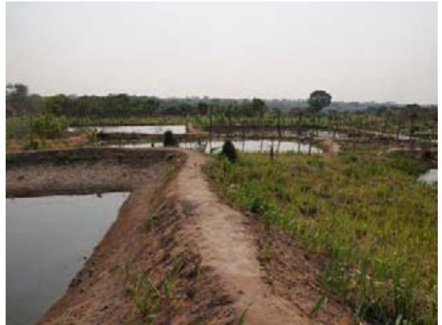
灌漑用水路は水を運搬するため、調査対象地域、中でもルアプラ州で実施したパイロット事業で多くの内水面漁業用の池が建設された。2年間のパイロット事業の間に183個もの養魚池が建設された。
