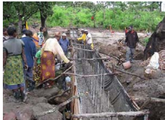
Chineke 取水堰の建設：2004 年順次工事がなされてきた。州および郡 TSB による直営工事である。
