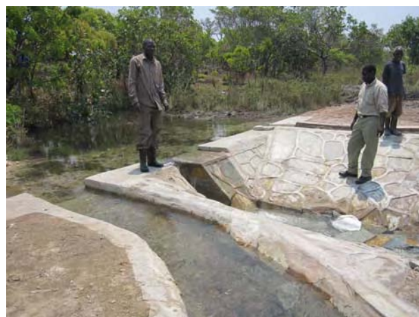
2010年11月にアップグレードされた練り石積み恒久堰の一例である。もともと右岸のみを灌漑していた簡易堰があったが、アップグレードに伴い左岸の村からも水路建設の要望が寄せられたため、両岸取水とした。
