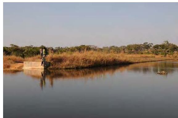
人力施工によるフィルダム；堤長 206m、堤高 6m の貯水ダムにより、現在 2.5ha の農地を灌漑している。
