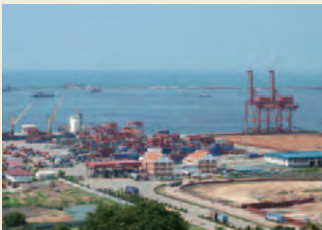
整備が進むシハヌークビル港経済特別区
