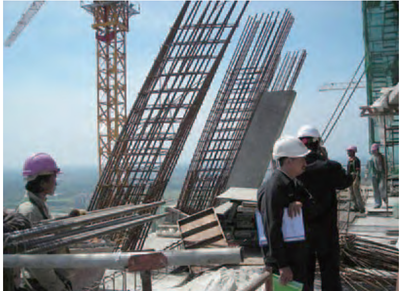
建設現場の安全監督の実習(マレーシア「労働安全衛生行政支援プロジェクト」)
