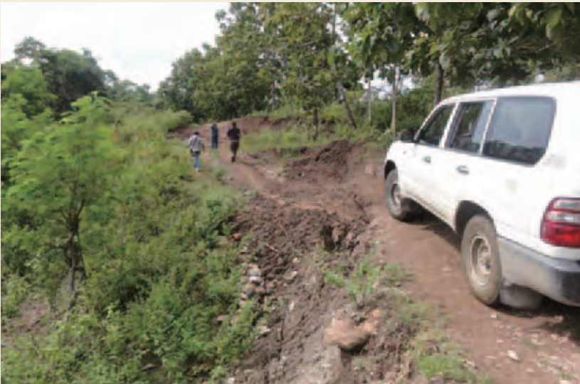
急峻な斜面が続く。多雨の影響もあり、道路環境は厳しい
