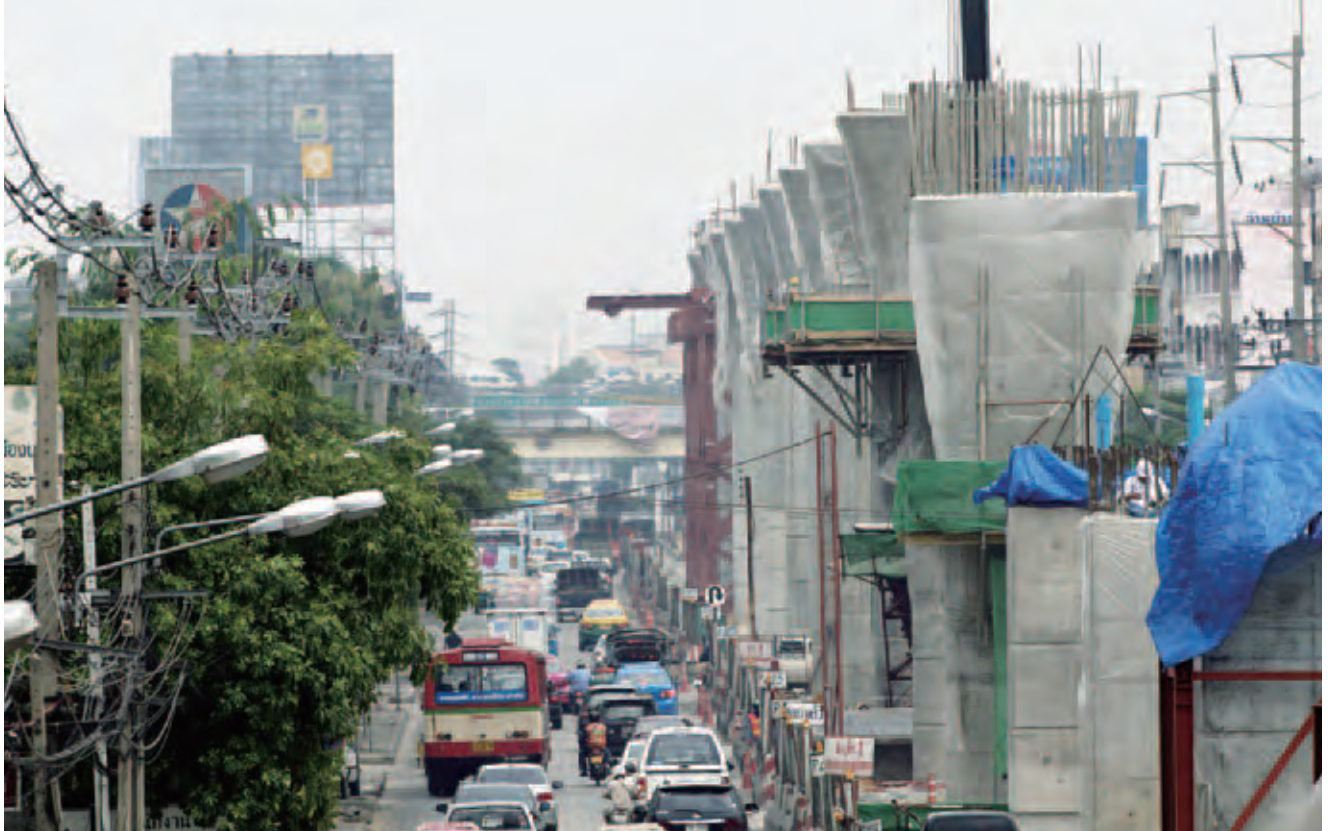
タイの首都バンコクでは、円借款の供与により、隣接するノンタブリ県とを結ぶ大量輸送鉄道パープルラインの建設が進んでいる
