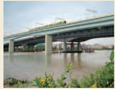
ホーチミン市中心部から郊外に向かい、サイゴン川の高架橋を渡る橋のイメージ図
