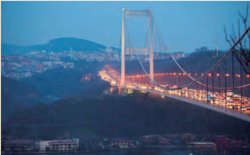
耐震補強工事が完了したイスタンブール長大橋
