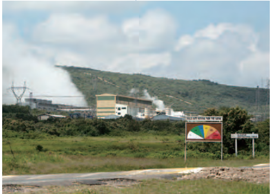
休火山のすそ野にあるケニアのオルカリア地熱発電所。2010年3月、JICAは同発電所の拡張を目的とした円借款貸付契約に調印。電力供給だけでなく、サブサハラ・アフリカ初の気候変動対策円借款の適用案件として地球環境負荷軽減への貢献も期待されている【撮影：久野真一】
