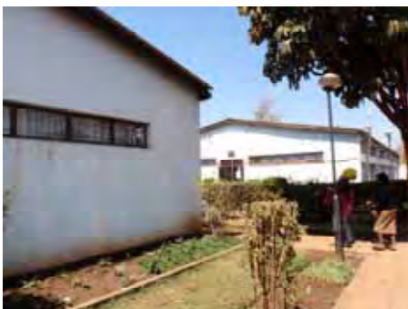
母子保健棟と産科病棟
