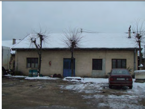
【既存の交換部品倉庫1】
