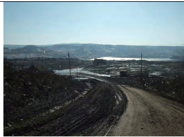
【オビリッチ処分場内部】
