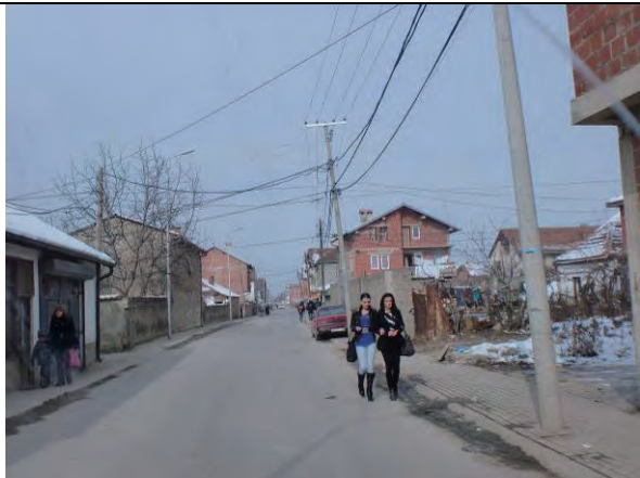
【プリズレン市の準幹線道路】 プリズレン市の準幹線道路。舗装された6～8m幅員であるが、車道と歩道の区別はない。
