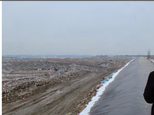
【プリズレン処分場内】
