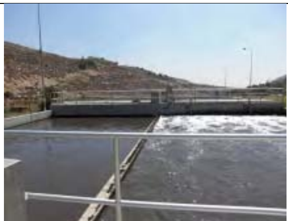
写真 - 12 アル・ビーレ市下水処理場: ドイツの援助にて建設された下水処理場。
