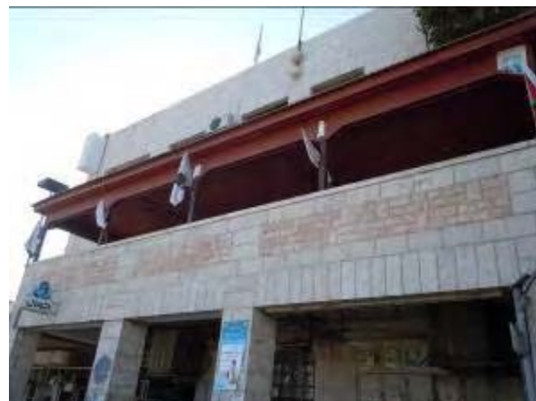
写真 - 1 ジェリコ市役所水道局：本オフィスにて実務的な作業を行っている。
