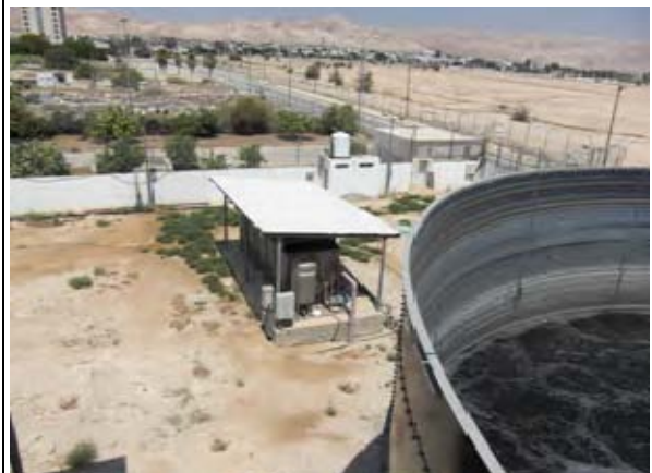
写真 - 10 インターコンチネンタルホテルの汚水処理施設: ホテルで利用した水をホテル内の汚水処理施設にて処理を行っている。
