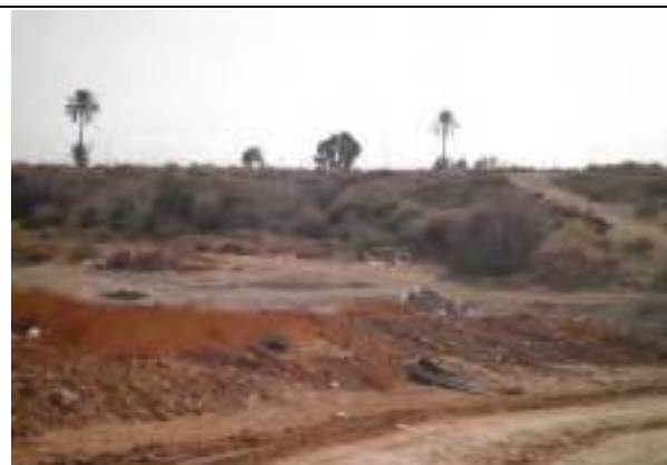
写真 - 3 ワジ（水無川）横断予定部：下水本管はワジの底部に設置され、向こう岸の下水処理場へ流下していく。普段は水がないので建設は容易である。
