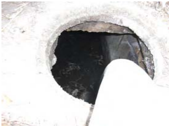
写真 - 9 セスピット: ジェリコ市内には公共下水道が無いいため、市民はセスピットに汚水を貯留し、収集車で汚水を排出する。
