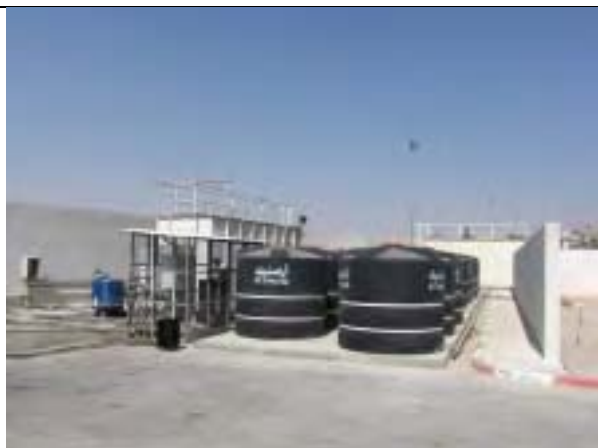
写真 - 11 大統領警護隊の処理場: キャンプ内の汚水は敷地内の処理場にて集合処理される。
