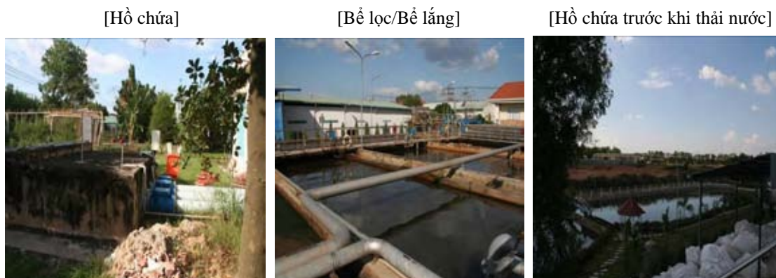
Sơ đồ 2-16 Ví dụ về công trình xử lý nước thải ở KCN đang hoạt động (LOTECO)
