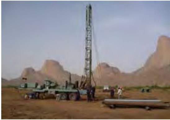
[本調査の試掘] 調査団は7本の試掘を行なって、地下水調査を実施した。
