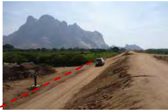
[導水管ルート] ガシ川堤防の法尻から10m以内の公用地が導水管のルートである。
