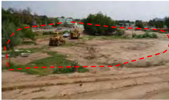
【マハタ浄水場・施設建設予定地】マハタ浄水場内の既存施設隣接地に新規の施設を建設する。給水サービスの継続性を維持するため、既存施設と新規施設は配管の切り回しにより切替える。
