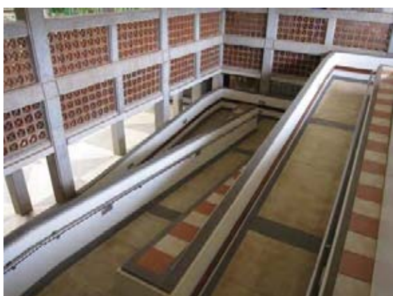
写真17. アフリカ人づくり拠点 (AICAD) 国の規準に従い、二階まで車椅子で上られるスロープを設置している。
