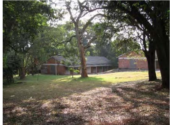
写真2. 敷地内の状況
