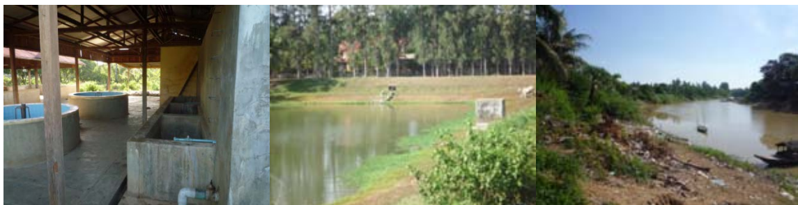
図 2-19 バッタバン州 FiA 養殖場 (左：孵化場内部、中：貯水池、水源の Sangke 川)
