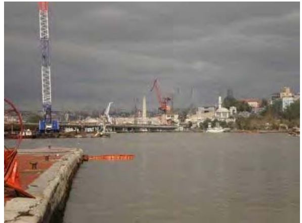
メトロ金角湾鉄橋の工事現場
