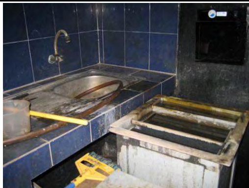
写真-5：暗室（コンポントム病院） X線フィルムの現像はマニュアルで行っている。機材は老朽化が顕著である。
