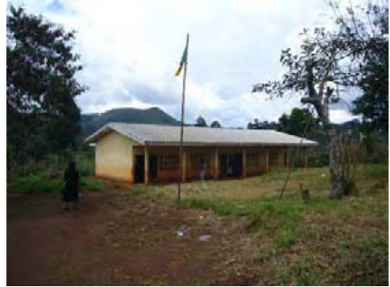
2007 年に PPTE 基金により建設された政府標準設計の教室棟。
