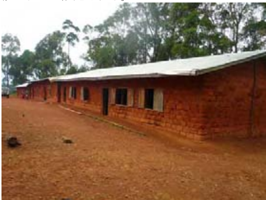
PTA によって建設された日干しレンガ造の校舎。
