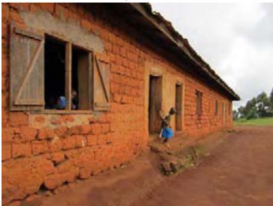
PTAにより1970年代に建設された校舎。
