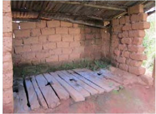
プライバシーが確保されない便所。
