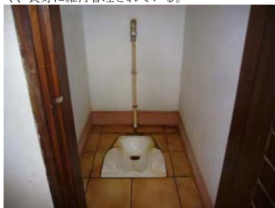
洗浄ボタンも当時の状態のまま機能している。
