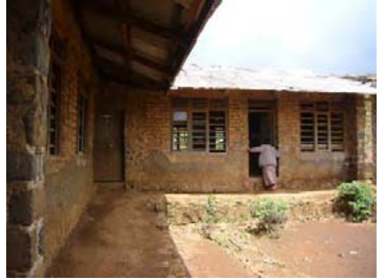
1960年代に建設された校舎は、増築が繰り返されている。
