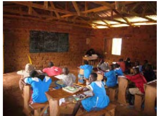
日干しレンガは開口面積が限定されるため、照度が不足している室内。
