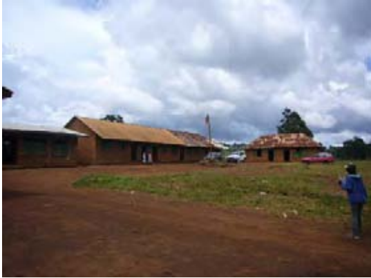
サイト全景。大部分は 1940 年代に建設された施設で老朽化が著しい。
