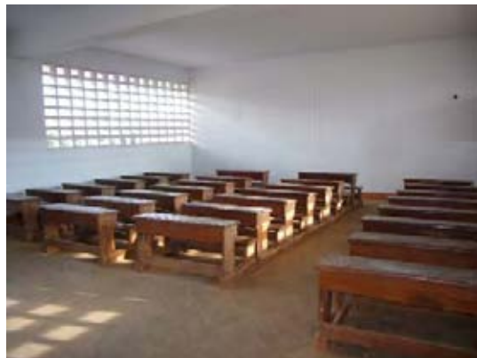
内壁も再塗装が実施されている。家具の破損も無く、良好に維持管理されている。
