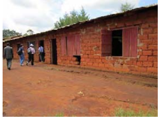
PTAにより建設された日干しレンガによる教室。
