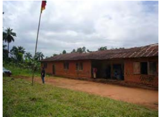
1961年にPTAにより建設された日干しレンガ造の校舎。
