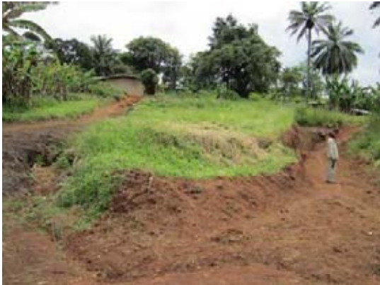
敷地は急傾斜地であるため、施設建設には大規模な造成工事が必要。
