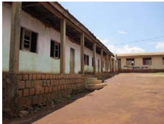
石及び補強コンクリートブロックによる組積造。
