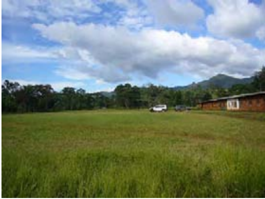
サイト全景。敷地は平坦で十分なスペースがある。
