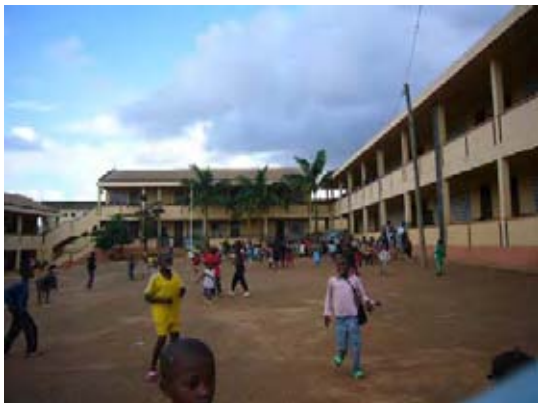
2000年に竣工。2010年に再塗装、建具の修繕が実施されている。
