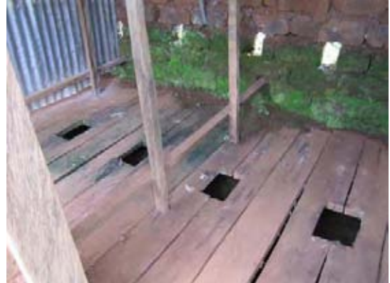
プライバシーが確保されない便所。
