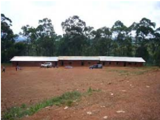
サイト全景。斜面地のため、比較的平坦な建設可能エリアは限定される。
