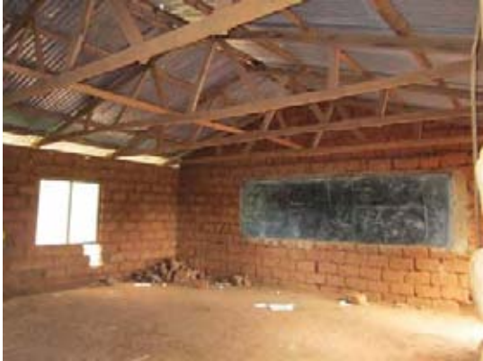
家具が整備されていない教室。
