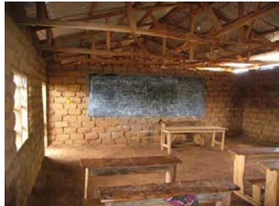
PTAにより建設された教室。
