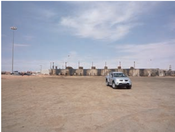
写真－9 原油積み替え広場：通商・取引広場に隣接する原油積み替え広場。原則イラク側から来たタンクローリーはここで原油を積み替えた後、イラクに戻る。
