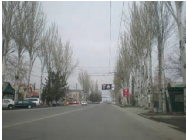
中央線は整備、車線区分線は未整備の道路
