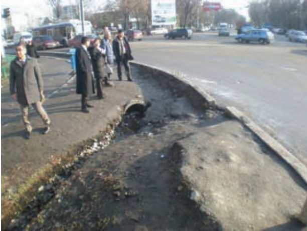
道路横断施設の不連続/側溝の整備不良 (Chui大通りと Yulius Fuchik 通りの交差点)
