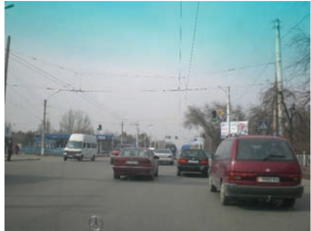
中央線、車線区分線共に未整備の道路
