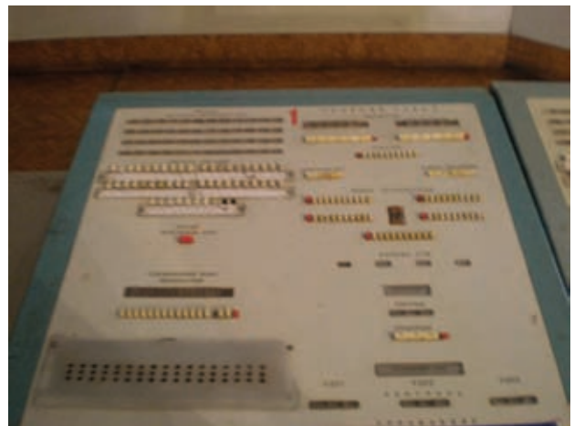
交通管制システム制御盤
