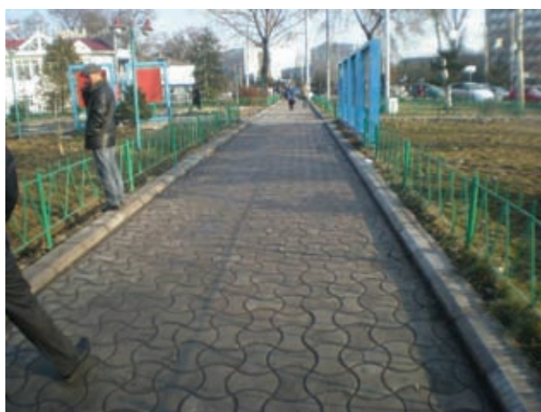
インターロッキングブロック、縁石で整備された歩道
