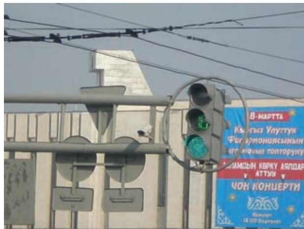
新型LED式信号機（カウントダウン機能付） +CCTVカメラ添架
