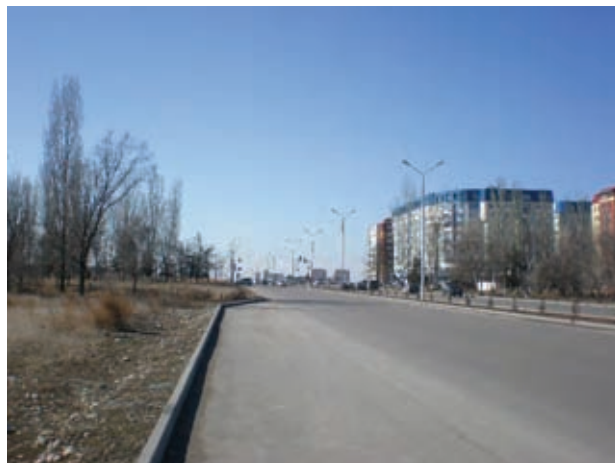
南幹線道路整備
