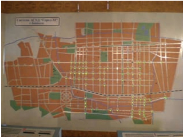
信号表示盤 (交通管制室/機材据付局内)
