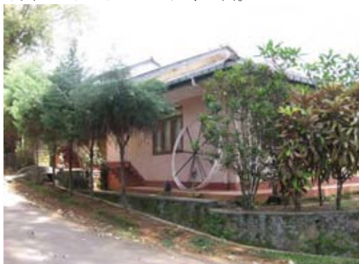
写真-3：青年海外協力隊(JOCV)活動支援経費によって建設された日本語センター(老朽化に伴い、学生寮に改修予定である)。
