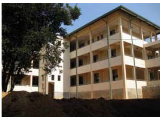
写真-7：社会科学言語学部の校舎2号館(1階中央部の教室にLLシステムを設置予定)。
