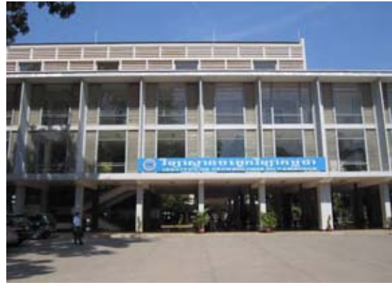
写真-2: 校舎正面玄関。
