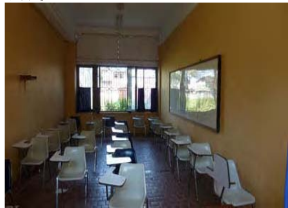
写真-12: X線回折装置、その他機材の保管場所に予定されている教室。空気調整設備を設置する予定。
