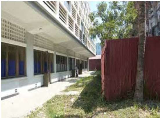
写真-9: 計画機材設置予定のB棟115、116、117教室の外観。
