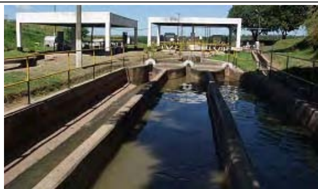
⑩-1 ルプト下水処理場の沈砂池
