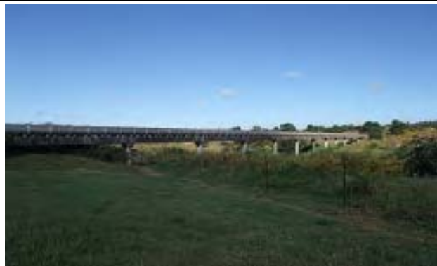
⑪-1 コンクリート製下水流入管水管橋
