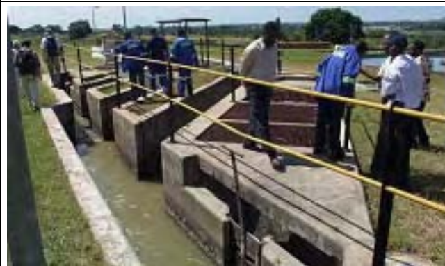
⑪-2 各系統への流入部とスクリーン
