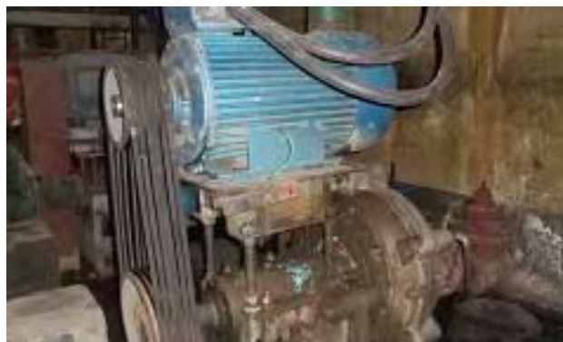
⑬ベルト駆動の横軸ポンプが2台稼動中
