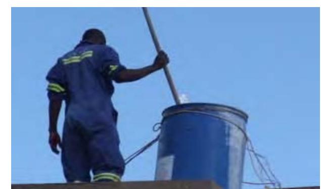
次亜塩素酸カルシウムを人力で溶解・攪拌して注入
