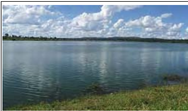
カフブダム (取水池)
