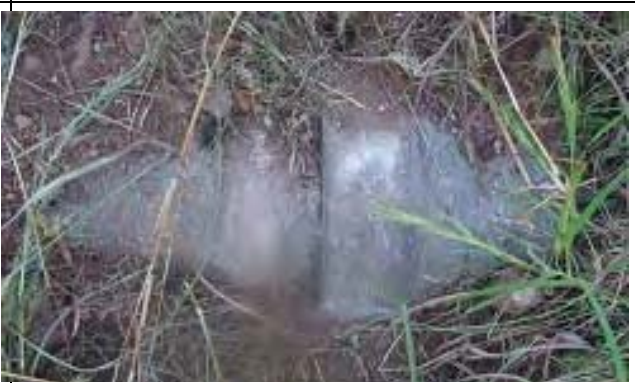
コンクリート管の差込継手
