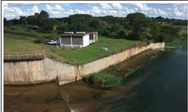
①取水ポンプ場 2 棟
