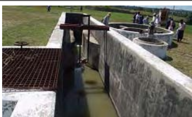
⑪-2 流入量計測水路 計測されていない
