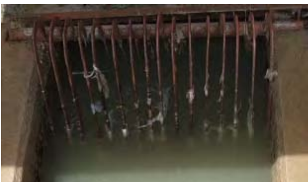
⑬ダンボポンプ場の流入部
