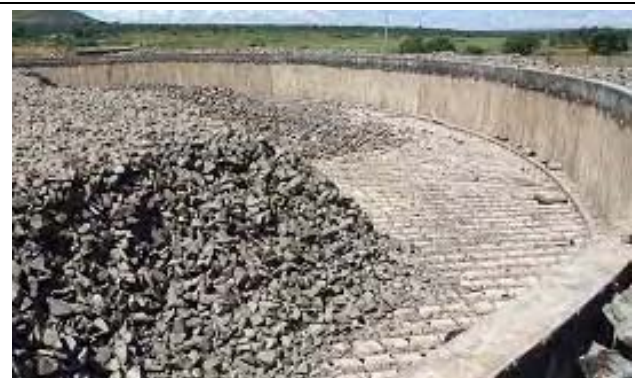
⑩-1 使われていない散水濾床槽と内部の礫層
