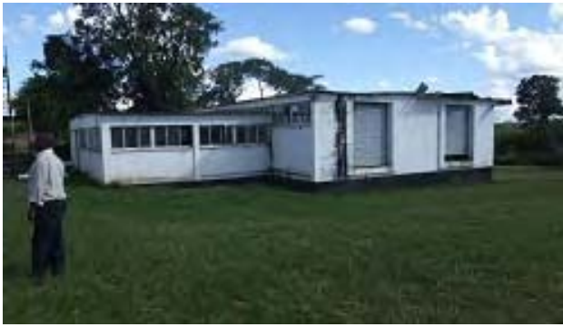
②カフブ浄水場 薬品室
