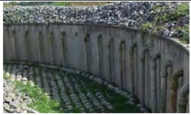
⑪-2 使われていない散水濾床槽の内部
