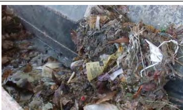
⑩-1 自動除塵機から掻き出されたし渣
