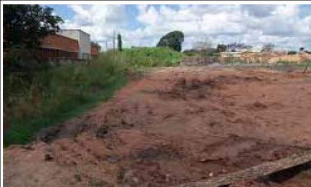
⑫工業地区の中の下水管路漏水箇所
