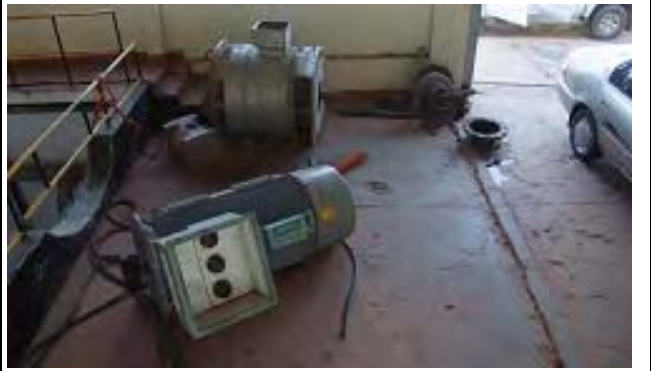
⑥取り外された電動機
