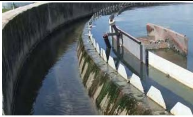
⑪-2 上澄水越流部の状況
