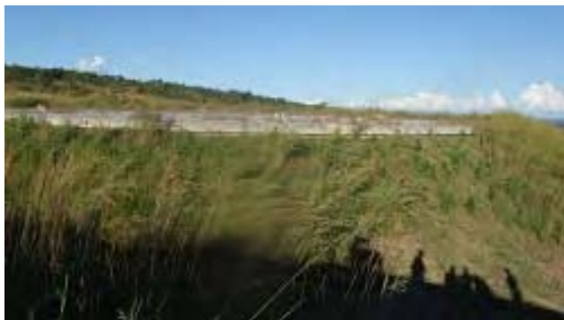
ナカプタ配水池
