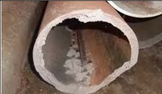
撤去された石綿セメント管 (AC管)
