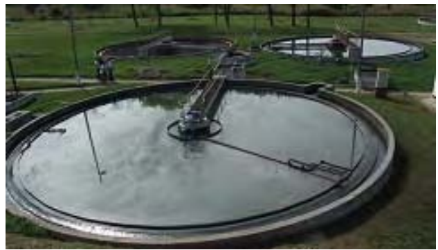
⑪-2 最初沈殿池
