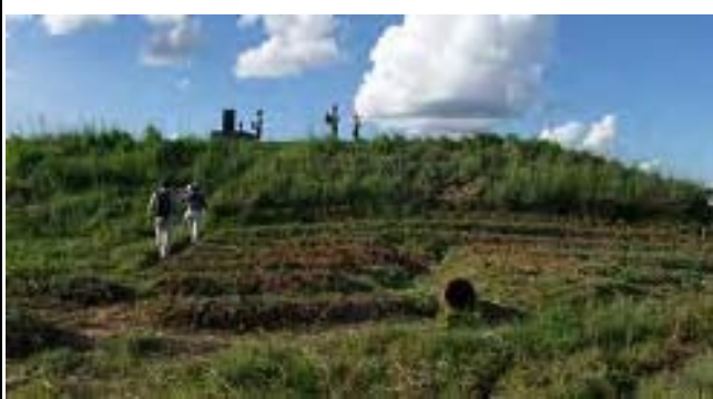
チフブ配水池
