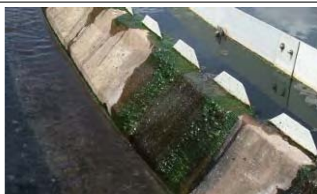
⑪-2 上澄水越流部の状況
