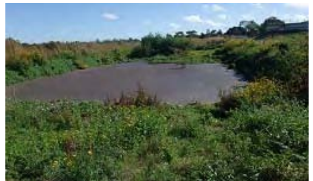
⑪-1 汚泥天日乾燥床
