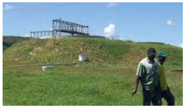
⑪-1 汚泥消化槽
