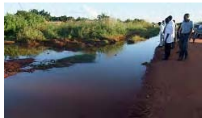
⑦送水管（コンクリート管）の漏水箇所
