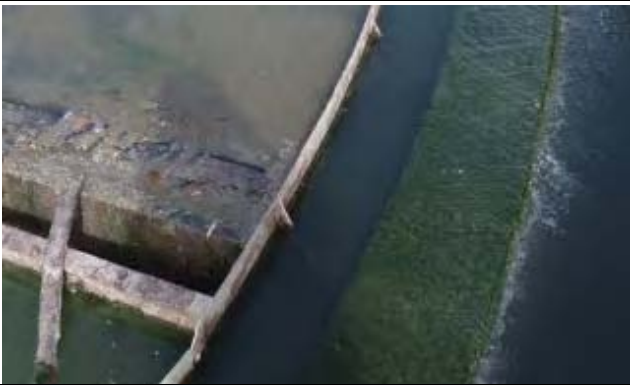
⑪-2 スカムと上澄水越流部の状況
