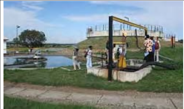
⑪-2 最初沈殿池からの汚泥引き抜きパイプと消化槽
