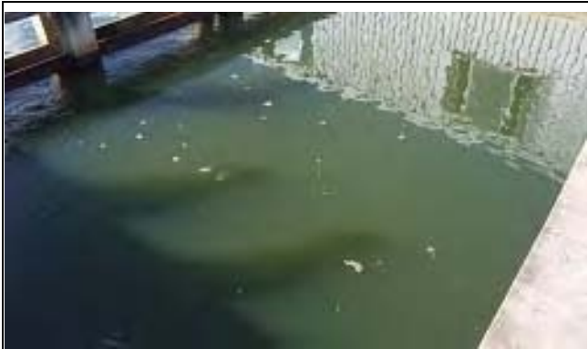
④⑤急速濾過池 濁っていて濾過砂が見えない
