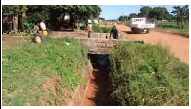
⑨排水側溝は整備されている
