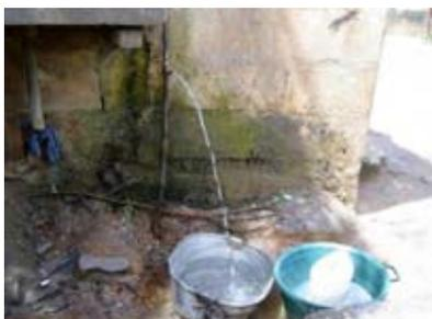
図 4-2-1 マサラ地区の定額制各戸給水（蛇口が壊れている）
