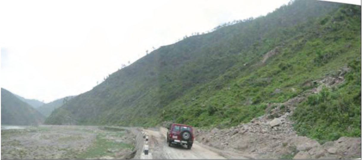
写真 3 - 7 斜面の状況 (Sta.5 側)
