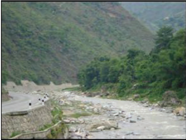
写真 3-9 河川の状況 (Sta.16+500 付近)
