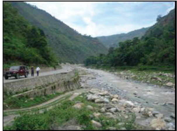
写真 3-10 河川の状況 (Sta.17+500 付近)
