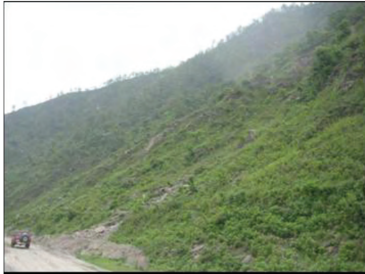
写真 3 - 8 斜面の状況 (Sta.6 側)
