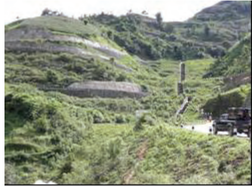
PII-2 STA12+500: 起点から終点を望む。正面の縦排水路は、206,000m 3 の建設余土の盛土斜面を利用して設置。
