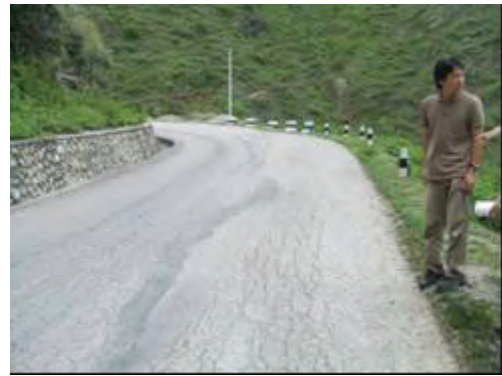
PIV-2 STA27 舗装補修箇所 盛土部分で沈下が発生している。
