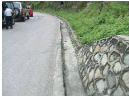
PIV-2 STA27 舗装補修箇所 盛土部分で沈下が発生している。
