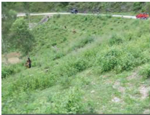
PIV-3 STA27 盛土箇所
