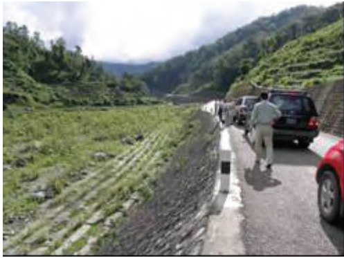
PII-1 STA5+300 護岸工+根固め工。
