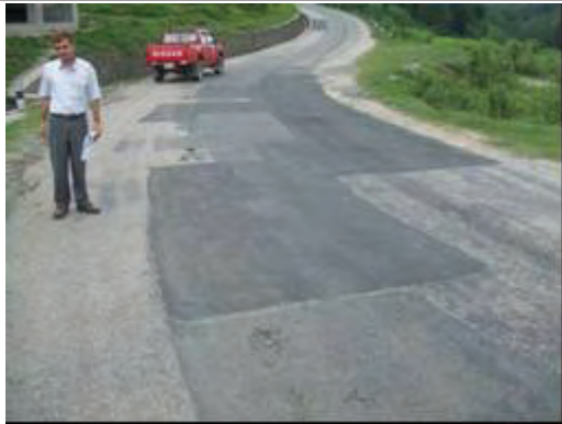
PIV-1 STA48+300 舗装補修箇所（終点より望む）
