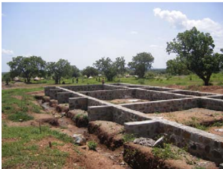
無償資金協力で建設中のジュバ教員養成校
